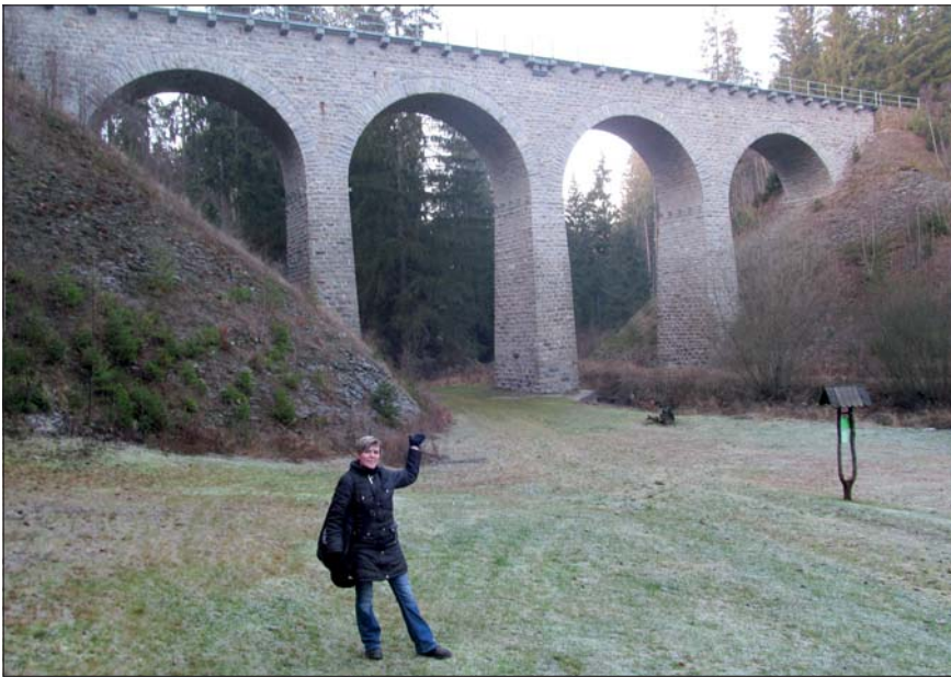
Viadukt nedaleko Vimperka z roku 1900
